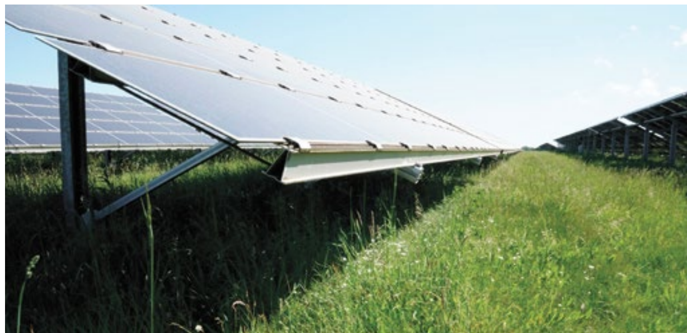
Für Vielfalt in der Freiflächenanlage sind u.a. die besonnten Bereiche und damit der Abstand zwischen den Modulreihen wichtig. Hier Solarpark Waldpolenz bei Brandis (Bild: BfN)
